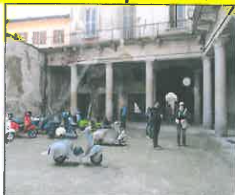
L'evidente degrado dello storico stabile
